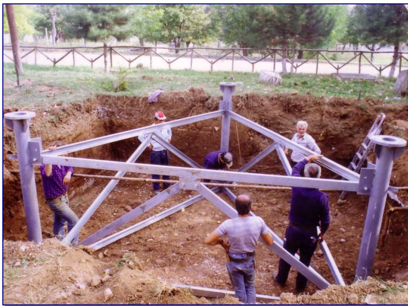
ΙΣΤΟΣ 30 ΜΕΤΡΩΝ ΣΥΣΤΗΜΑΤΟΣ ΣΕΖΜ ΕΡΜΗΣ ΚΑΙ Η ΒΑΣΗ ΤΟΥ ΠΡΙΝ ΤΟ ΣΚΥΡΟΔΕΜΑ
