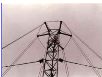
ΚΕΡΑΙΑ ΠΤΥΣΣΟΜΕΝΗ TACTICAL ΓΙΑ ΣΤΡΑΤΙΩΤΙΚΗ ΧΡΗΣΗ (ΙΔΙΑΙΤΕΡΗ ΠΡΟΣΟΧΗ ΣΤΑ 4 RADIALS ΑΠΟ ΦΑΡΔΙΑ ΤΑΙΝΙΑ)
