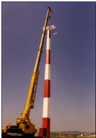
30 ΜΕΤΡΑ ΕΞΑΓΩΝΟΣ ΙΣΤΟΣ ΓΙΑ ΦΩΤΙΣΜΟ ΑΠΡΟΝ ΑΕΡΟΔΡΟΜΙΟΥ ΚΕΡΚΥΡΑΣ
