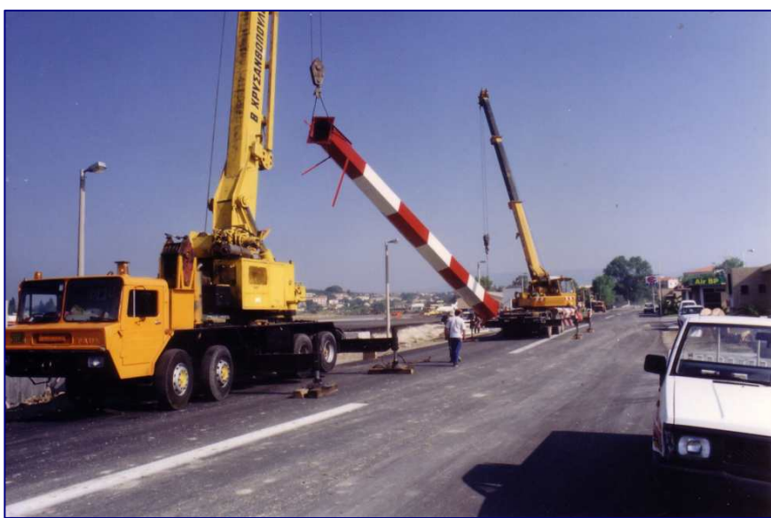
30 ΜΕΤΡΑ ΕΞΑΓΩΝΟΣ ΙΣΤΟΣ ΓΙΑ ΦΩΤΙΣΜΟ ΑΠΡΟΝ ΑΕΡΟΔΡΟΜΙΟΥ ΚΕΡΚΥΡΑΣ
