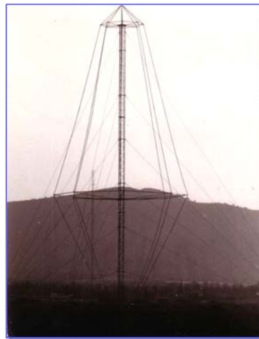
2-30 ΜΗΖ 100 KW ΚΑΤΩ ΣΟΥΛΙ
