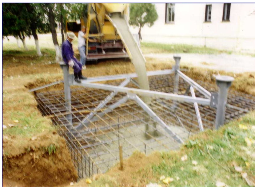
ΠΛΗΡΩΣΗ ΤΗΣ ΒΑΣΕΩΣ ΜΕ ΣΚΥΡΟΔΕΜΑ
