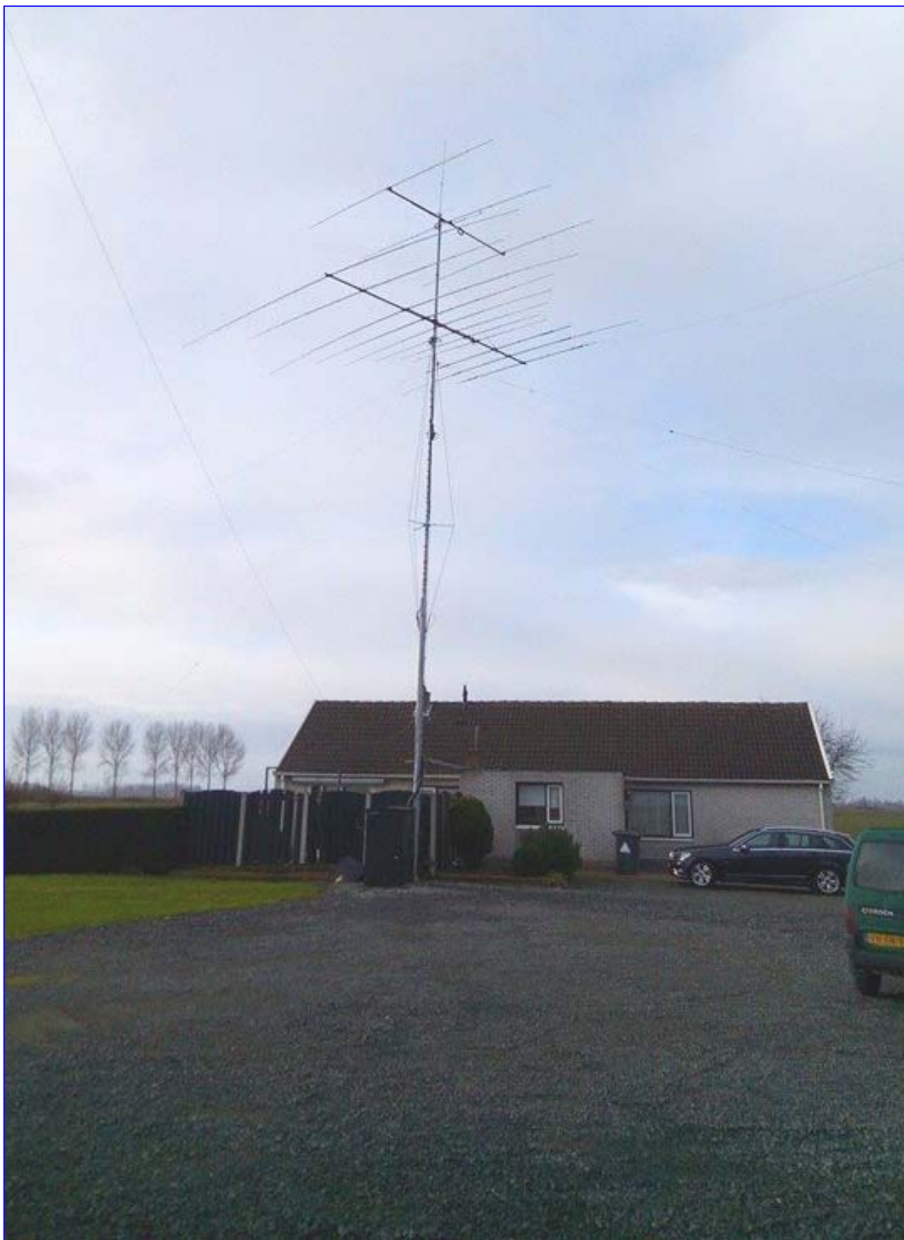
Ο τρίτος πύργος έχει ύψος 12 μέτρα και διαθέτει 1) 11 element HYGAIN TH11DX για τις WARC μπάντες και για τον σταθμό multiplier
