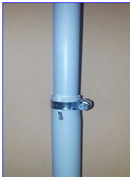
Στήριξη της κεραίας μέσα σε σωλήνα Φ25
